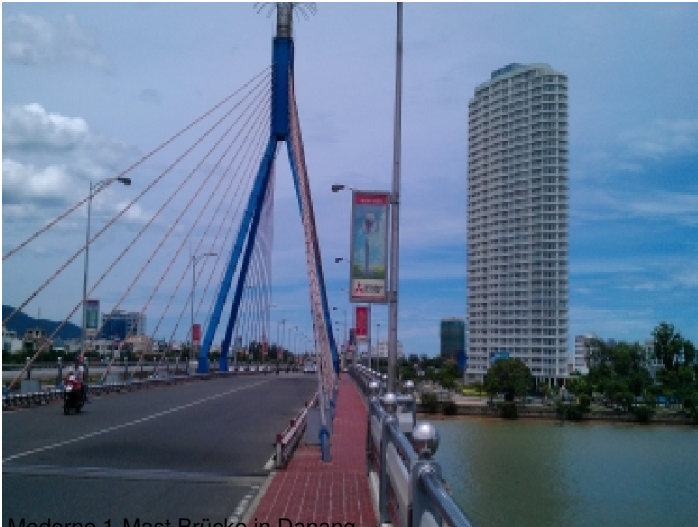
Moderne 1-Mast Brücke in Da nang
