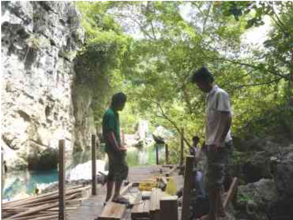
Im Juni 2011 wurden gerade die Stege gebaut.
